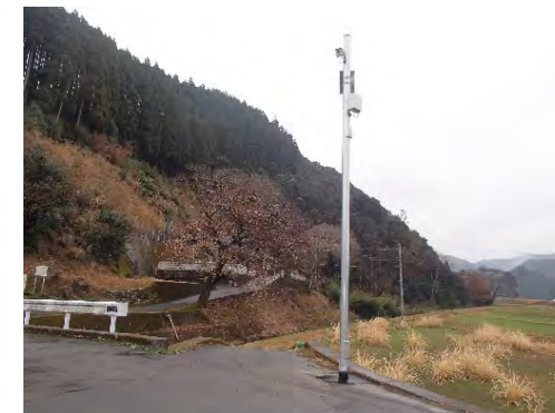
簡易カメラ設置例： 家田川 家田地区 (北川町)
